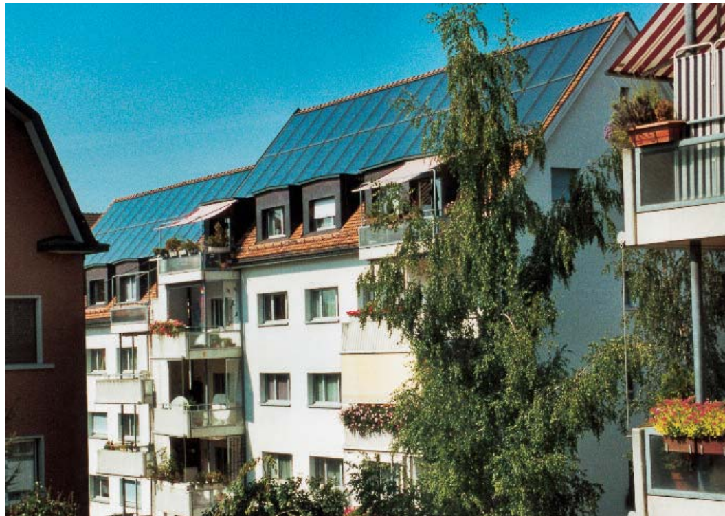
Einbau-Kollektorfeld in der Siedlung Freiblick, Zürich
