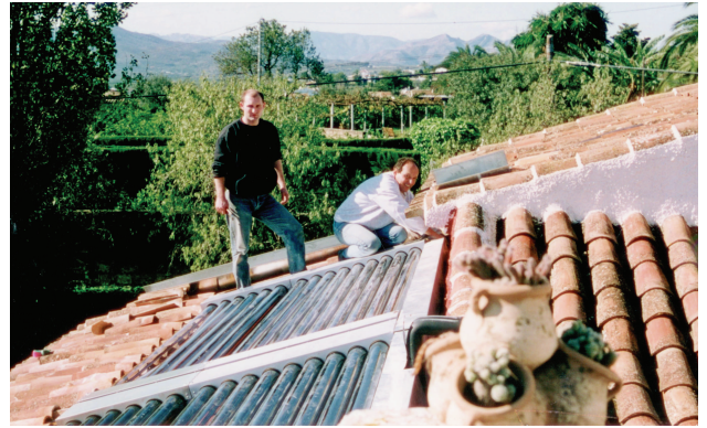
Montage Vakuumröhrenanlage Denia, Spanien, 1998
